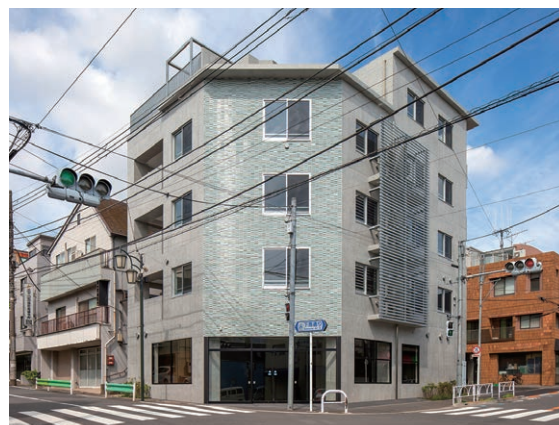
壁面のタイルがポイント
