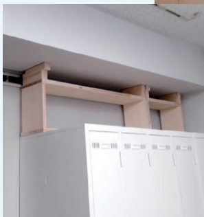
HPブログにて、実際に転倒防止器具を設置した様子を公開中
